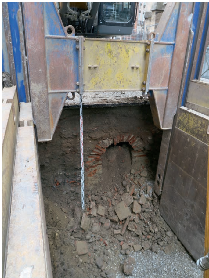
TOULOUSE. RUE SAINTE-ANNE. La conduite d'amenée de l'« aqueduc de Guilheméry ». Cl. Chr. Calmés, Cellule Archéologie de Toulouse Métropole, 19-04-22.
